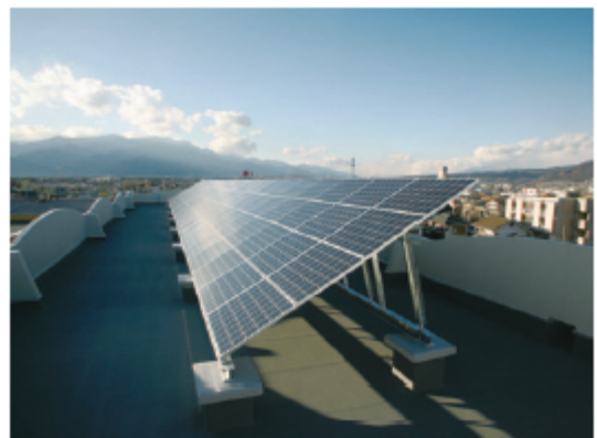
校舎屋上に 20kW の太陽光パネル
